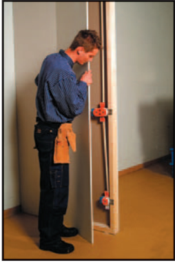
Montera gipsplattan / panelen.
