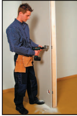
Borra hål med hålborr, ställ borret så långt ut som möjligt.
